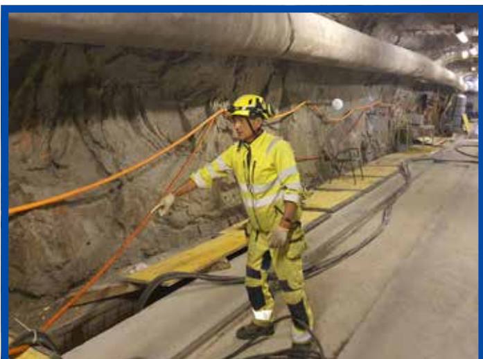
Bekir Yüce al lavoro nel tunnel © BedrettoLab.
