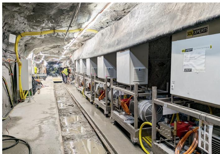
L'elevata pressione necessaria per l'esperimento è stata generata da una serie di pompe.
